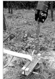
7.- Colocar la segunda pinza a la distancia L-50 cm desde la pinza que está en la boca del pozo e izarla fuera con la grúa hasta la altura máxima.
