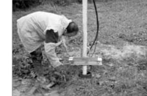
9.- Roscar la pieza de suspensión al racor superior. Conectar el gancho de la grúa a la pieza suspensión.
