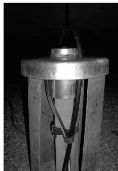
11.-Retirar la eslinga y el rodillo. Ya se puede proceder a las conexiones eléctricas, válvula, etc..
