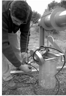
8.- Roscar la pieza de suspensión en el racor superior y cambiar la eslinga de tracción, desconectarla de la pinza y engancharla a los ganchos de la pieza de suspensión. (Ó al cáncamo de montaje).
