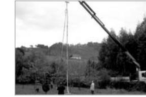
8.- Retirar la pinza inferior, que se hallará suspendida, y hacer descender la pinza superior hasta la boca del sondeo.
