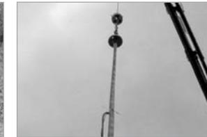
11.- Retirar la pinza y descender la pieza de suspensión. En este momento deben apretarse de nuevo los tornillos tensores de la abrazadera.
