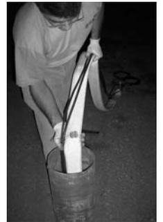
5.- Una vez introducida toda la tubería, colocar la pieza de suspensión sobre la boca del sondeo procurando que quede centrada.
