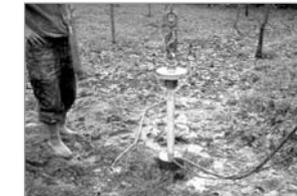
12.- Apoyar la pieza de suspensión en la boca del pozo y retirar la eslinga
